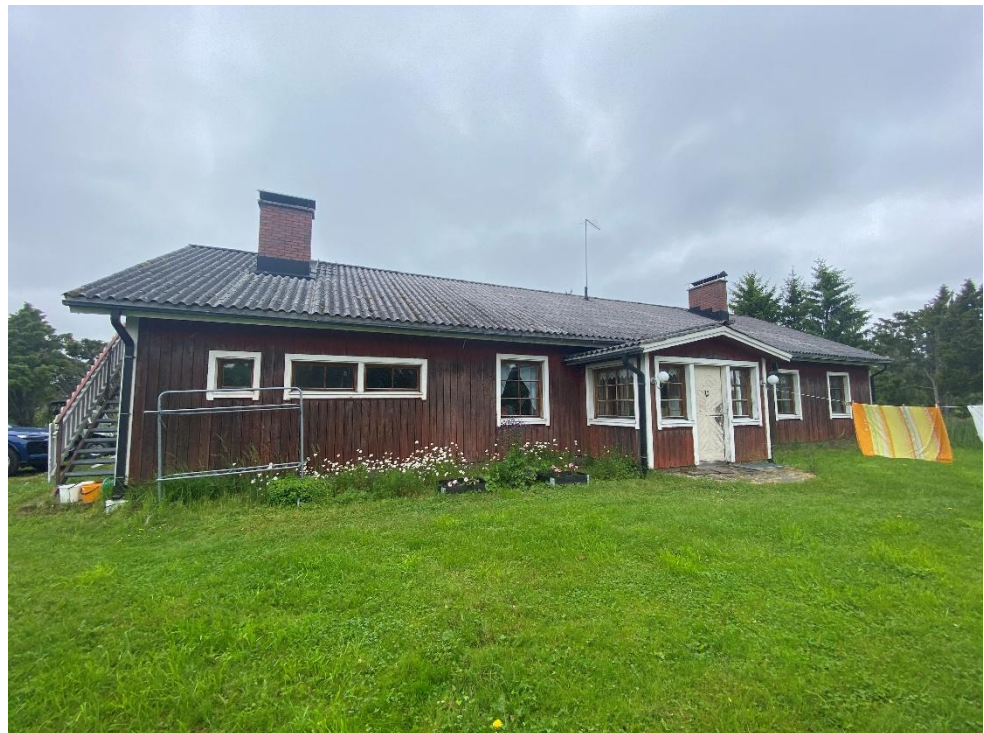
Suunnittelualueen 2 maatilakeskuksen päärakennus.
