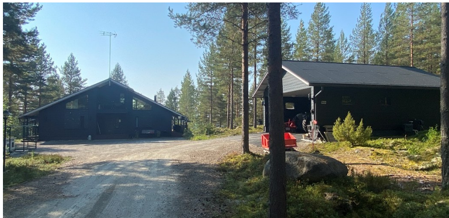
Olemassa olevaa rakentamista Väliveden itärannalla kiinteistöllä 989-402-2-73.
