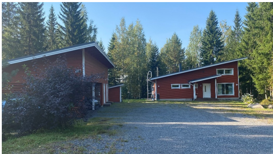
Olemassa olevaa rakentamista Väliveden itärannalla kiinteistöllä 989-402-2-77.
