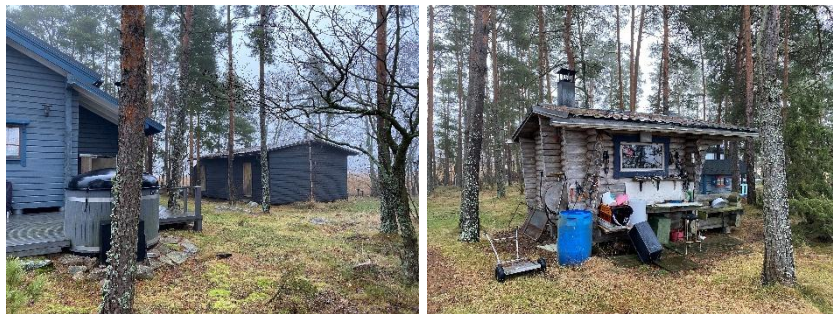
Kiinteistöllä 833-429-2-82-M604 YLI-JUNNILA olevat piha- ja saunarakennus.
