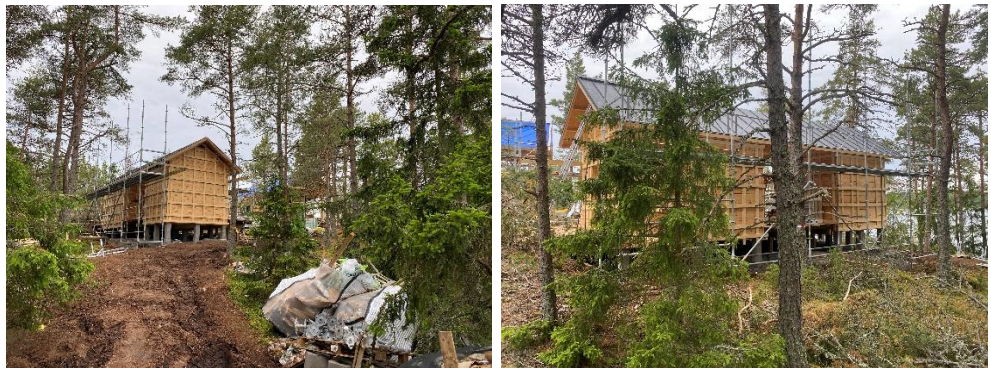
Suunnittelalueen koillisimmalle rakennuspaikalle rakentuva talousrakennus.
