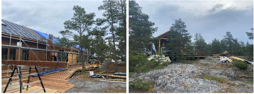
Fritidshus som uppförs på den nordostligaste byggplatsen i planeringsområdet.
