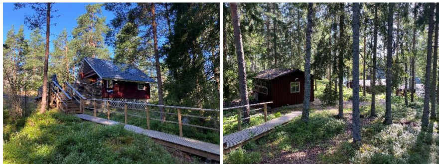
Den mindre inkvarteringsbyggnaden (färdigställd 1986) med tillhörande ekonomibyggnad.
