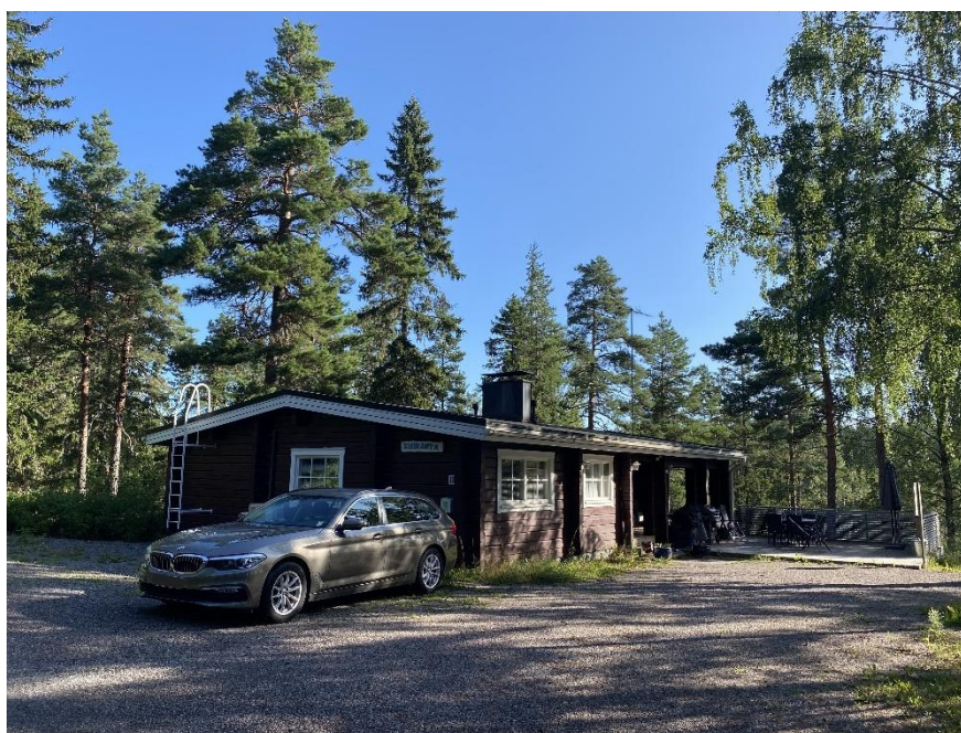
Inkvarteringsbyggnaden (huvudbyggnaden, färdigställd 1984).
