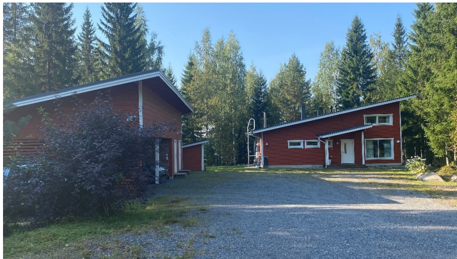
Olemassa olevaa rakentamista Väliveden itärannalla kiinteistöllä 989-402-2-77.
