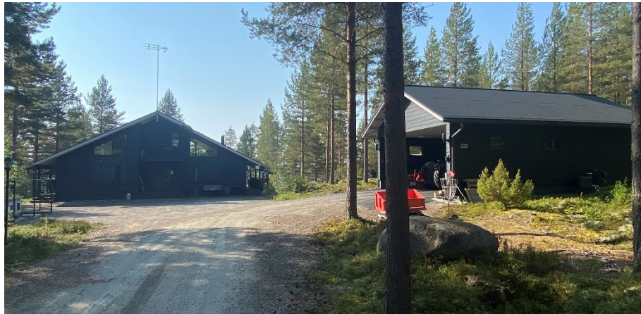
Olemassa olevaa rakentamista Väliveden itärannalla kiinteistöllä 989-402-2-73.
