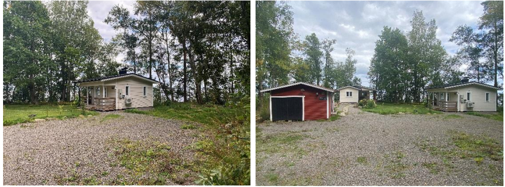
Suunnittelualueella 2 korttelin 8 rakennuspaikalla 3 (kiinteistö 50-406-13-32 HELMIKARI) oleva vapaa-ajan asuinrakennus talousrakennuksineen.
