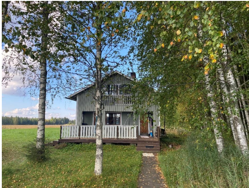
Suunnittelualan vapaa-ajan rakennus.
